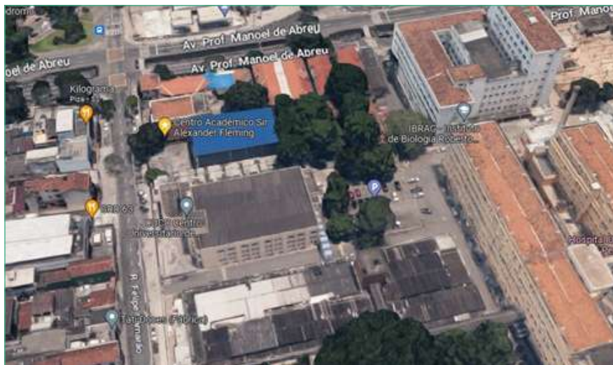
Vista aérea do HUPE e FCM. A seta assinala o ginásio de esportes (em azul)
